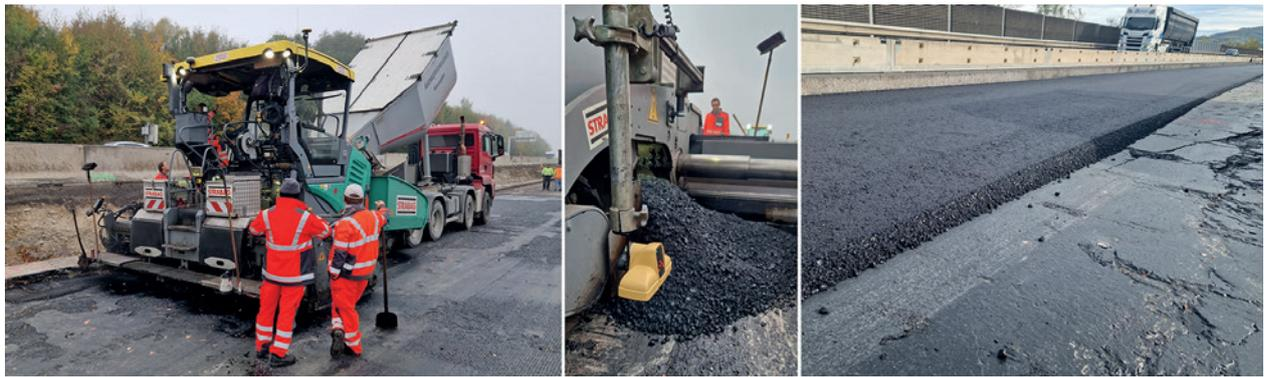
Abb. 15 | Ausführung der Asphaltaufbringung (Profilierungsschicht) mithilfe des 3D-Asphaltfertigers. Man erkennt rechts die variable Schichtdicke von 3–12 cm.
