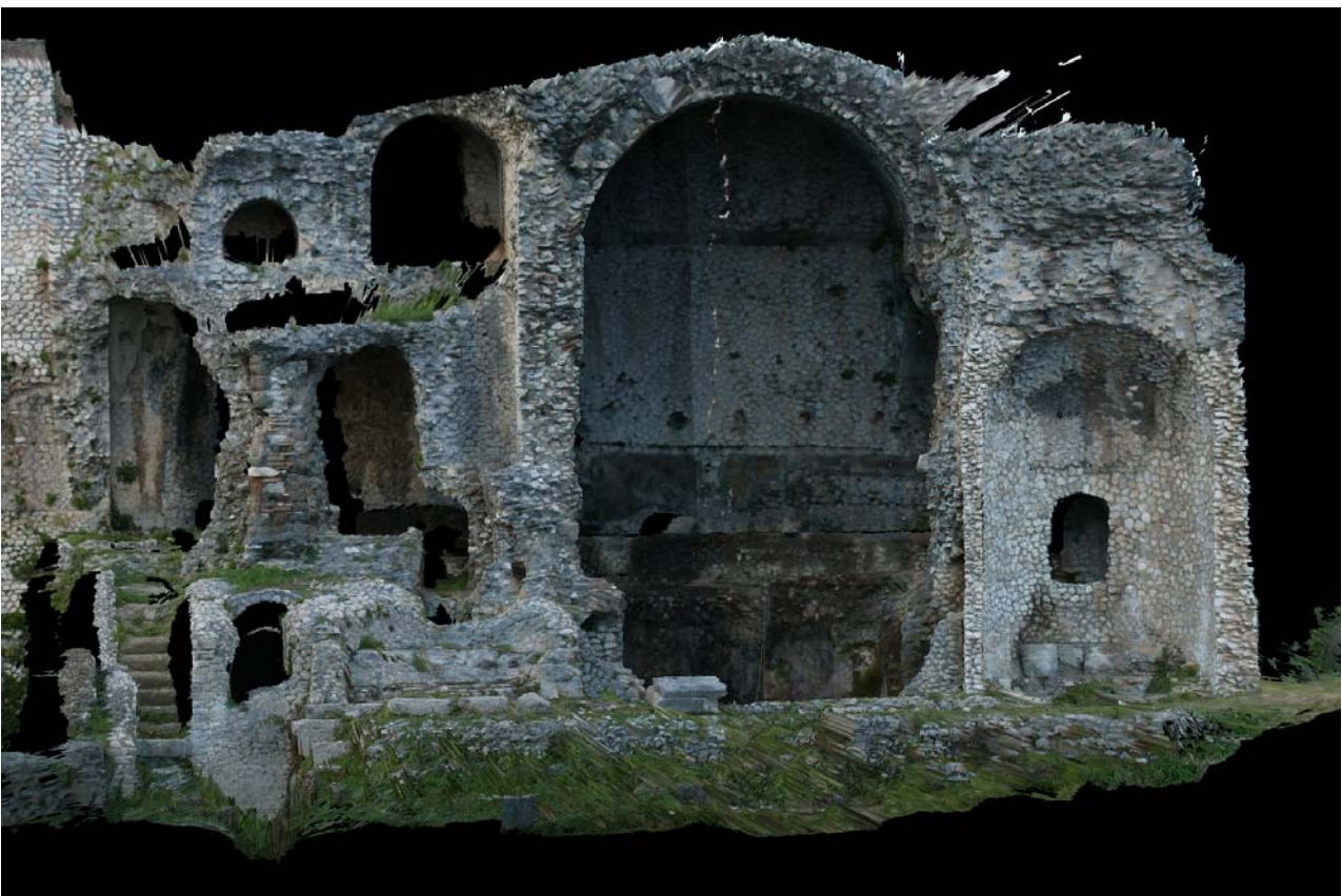
Fig. 11 – Palestrina, Propylon, westlicher Monumentalbrunnen, Südseite, Orthophoto der Hauptansichtsseite als Produkt aus Laserscanning und Photogrammetrie, Verwendung dreier Scanpositionen
