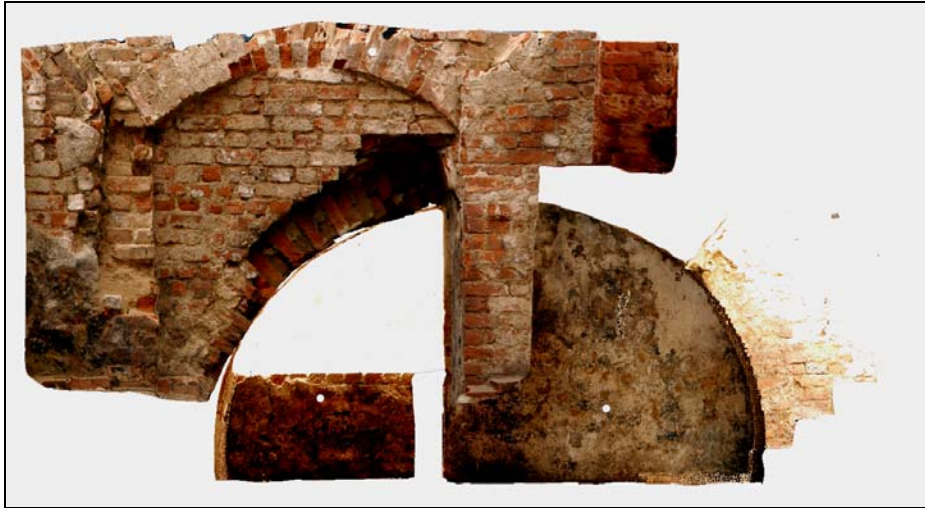
Abb. 30: Zusammengesetztes Orthofoto aus mehreren Einzelbildern erstellt in PHIDIAS.
