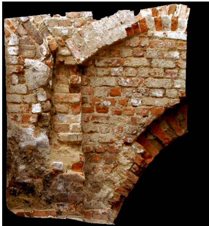
Abb. 29: In PHIDIAS erstelltes Orthofoto eines Einzelbildes.
