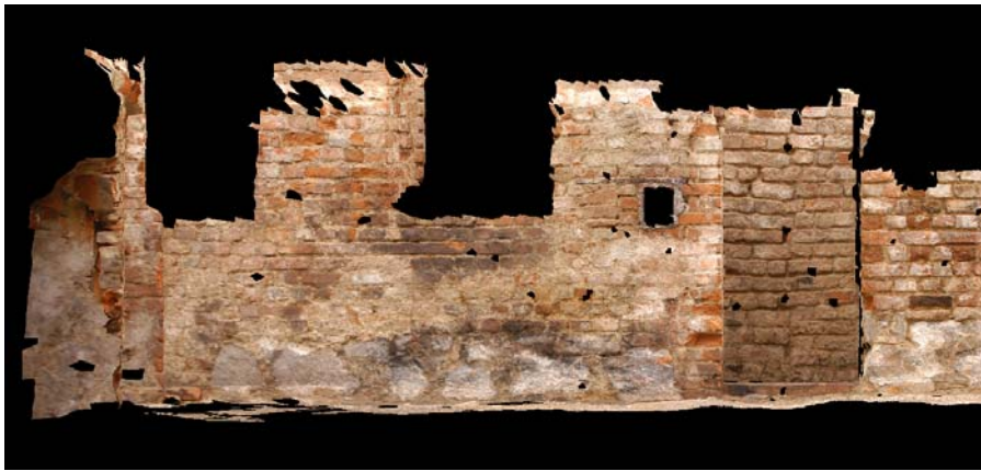
Abb. 22: In RiSCAN PRO erstelltes Orthofoto eines Detailbereichs der Nordmauer des Kellerraums.
